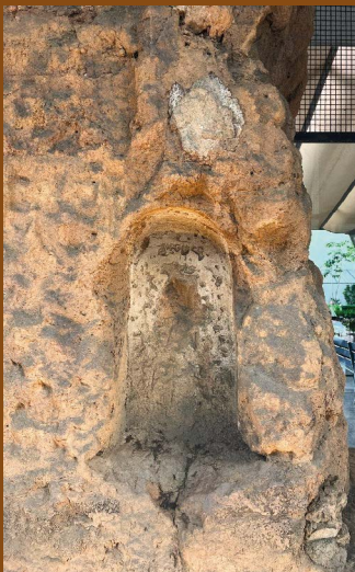
Detalhe da parede de taipa remanescente da construção original do Pateo do Collegio. Foto: Museu da bolsa do Brasil.
