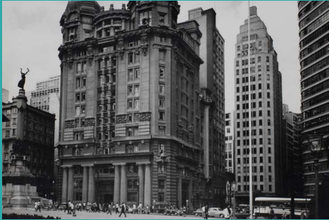
Fachada do antigo Palácio do Café, prédio que abrigou a Bolsa de Fundos Públicos de São Paulo de 1930 a 1972, situado na Rua Pateo do Collegio, nº 73. Foto: Acervo do Museu da bolsa do Brasil.
