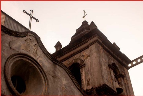
Detalhe da fachada da Capela dos Aflitos em abril de 2024. Foto: Acervo da Amusa – Associação Museu dos Aflitos.
